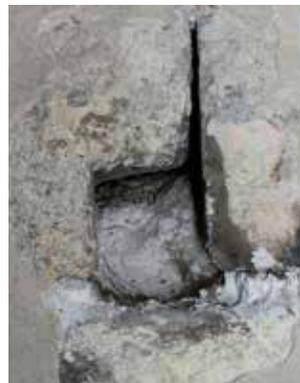
→ **Débouché intérieur (en cours de fouille) d'un trou de boulin situé près des roses et débouché extérieur (obturé par un cache boulin). Ces trous de boulins dits « traversants » percent les murs de part en part et permettent d'échafauder l'intérieur et l'extérieur du bâtiment en même temps.**
