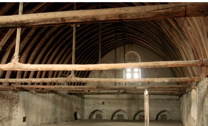
Vue de la charpente du Parloir aux Bourgeois
