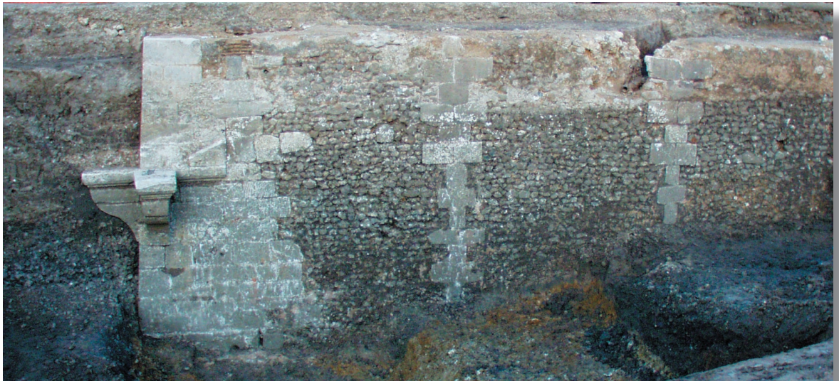
Mur sud du ravelin défendant la porte des Épars. XVI e siècle. Ci-dessous : détail des consoles qui supportaient une échauguette d'où l'on surveillait les fossés.
