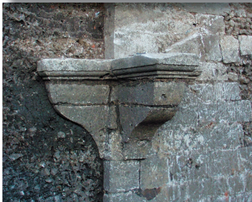
Mur sud du ravelin défendant la porte des Épars. XVI e siècle. Ci-dessous : détail des consoles qui supportaient une échauguette d'où l'on surveillait les fossés.
